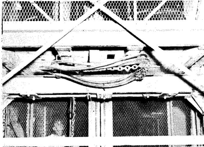
Fig. 45:- Vista demostrando una percha para almacenar cable adicional de reposición para el cable de control eléctrico.
